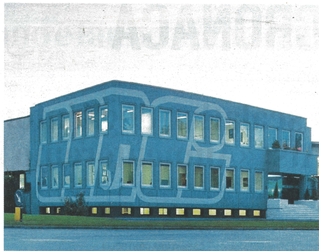
La sede dell'azienda di trasporti internazionali Messaggerie del Garda
